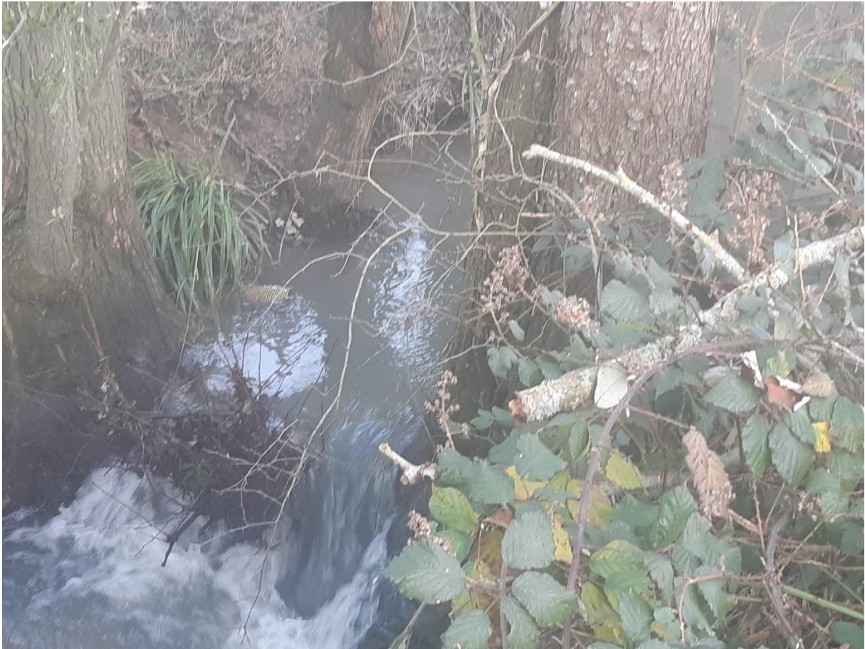
Figure 4 : Chute résiduelle due à un embâcle entre les racines
